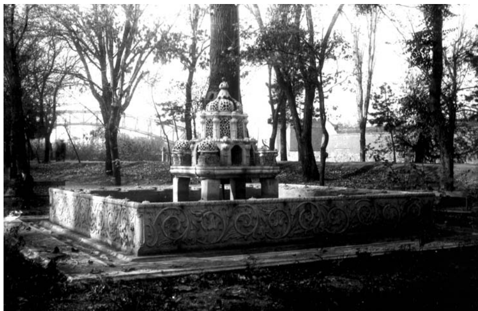
Сл. 42 Шедрван-водоскок испред беџовог конака (необјављено)
