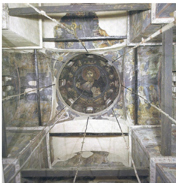
Сл. 7 Грачаница поглед на сводове Fig. 7 Gračanica, a view of the arches
