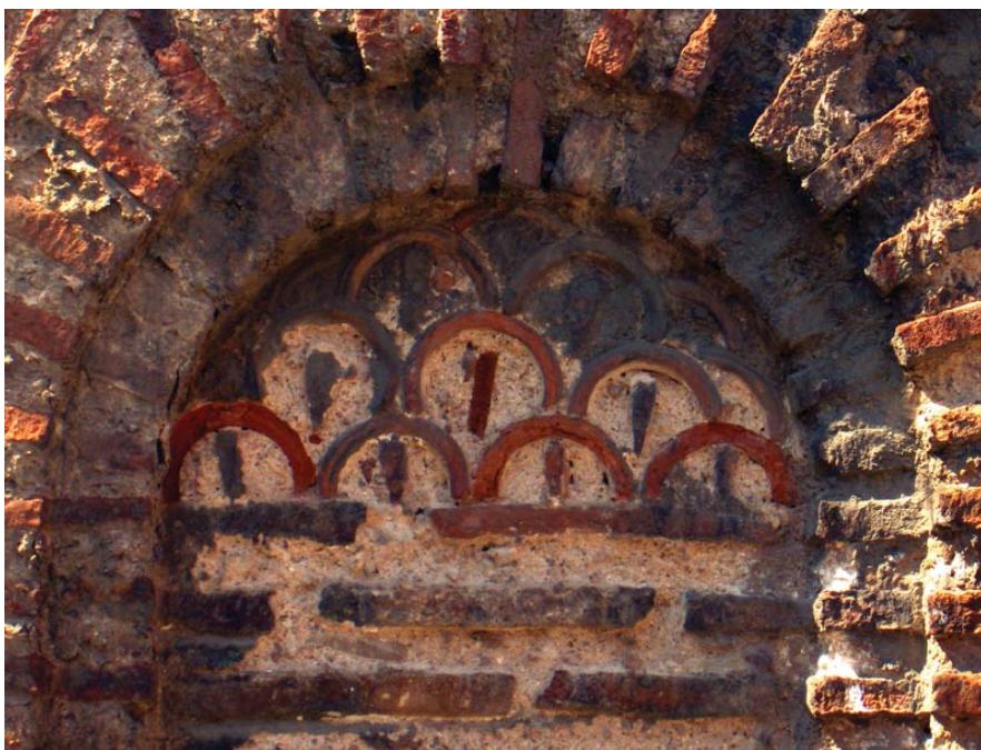
Сл. 18. Опеке потковичастог облика Fig. 18. Horseshoe-shaped bricks
