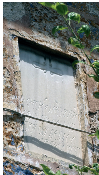
Сл. 9 Камена плоча са ћириличним натписом на јужној фасади цркве, фото: аутор
