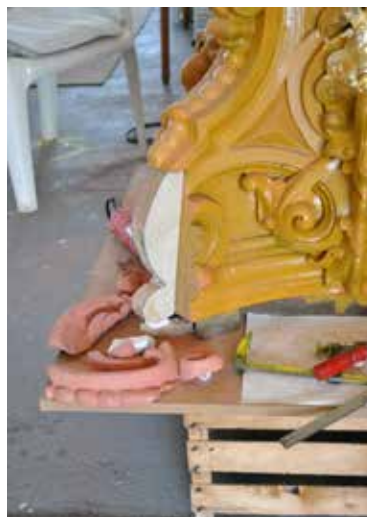
Сл. 12 Прва фаза реконструкције ногара (снимак аутора)
