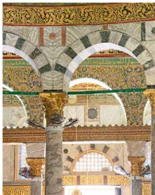
Сл. 3 Купола на стени, унутрашњост, детаљ, (959–1551/1552)
