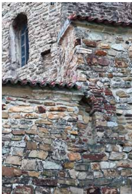
Сл. 4а Слепа ниша на северном зиду цркве пресечена приликом доградње апсиде (детал са фотографије В. Видосављевића)
