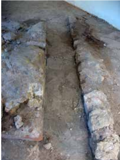
Abb. 6. Remesiana (Bela Palanka). Zivil basilika. Kanalfür die Wasserleitung für das Baptisterium, westlich der Apsis. (Foto: A. Soroceanu)
