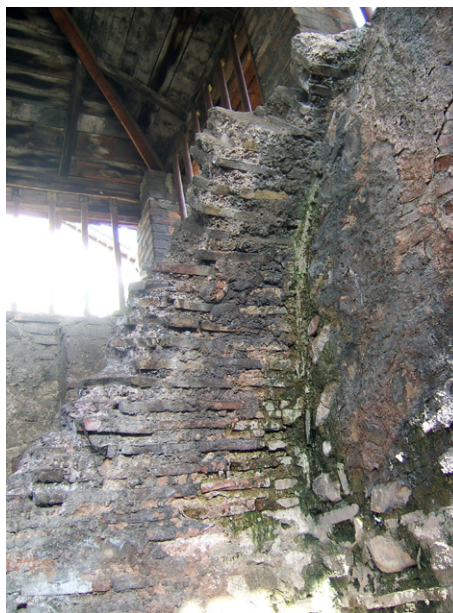
Сл. 9 Мартријум, сачуван сегмент лука полуобличастог свода (фото. М. Ракоција)
