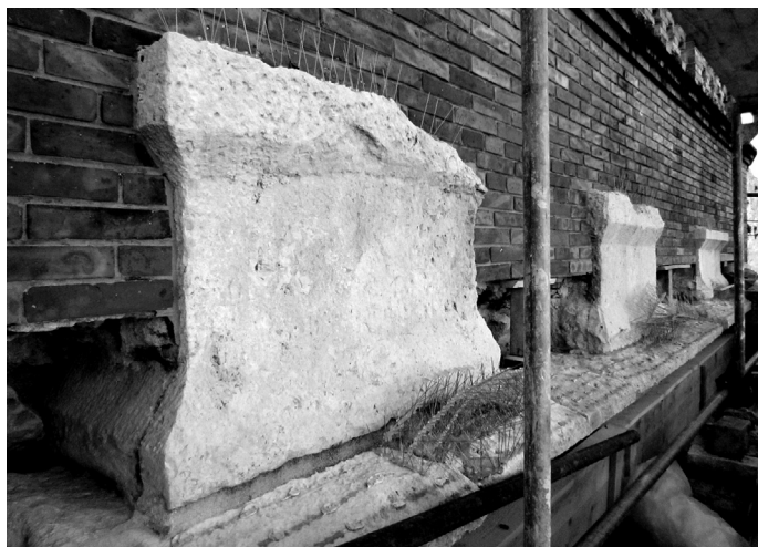
Sl. 9. Sondiranje oko kamenih rimskih „postamenata“ navrh pročelja Zlatnih vrata. Dužina im je znatno veća od širine.
