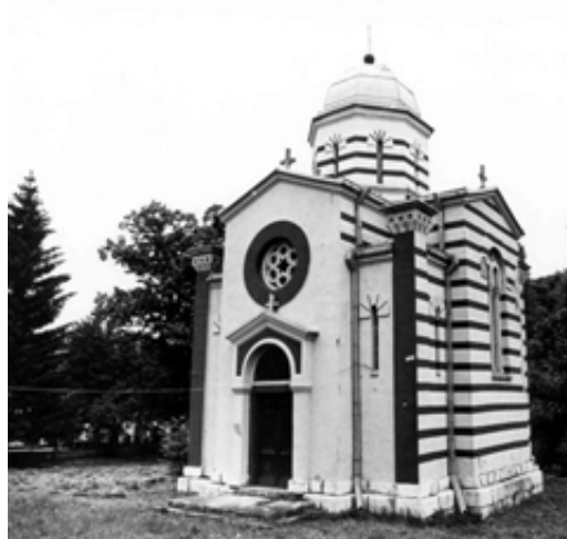
Сл. 2. југозападна страна (фото Републики завод за заштитиу споменика)
