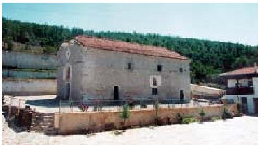
сл. 1 Манастирска црква, изглед након скидања малтерног покривача photo 1. The architecture of the church after the cleaning of the mortar
